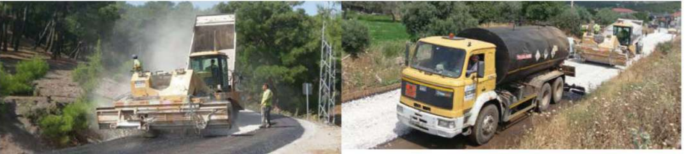
İşin Adı : Köşk Dalama yolu ilçe sınırı ve Yavuz köy yolu asfalt kaplama işi
