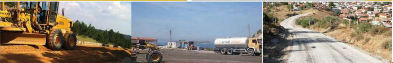
İşin Adı : Eskişehir İli Seyitgazi ilçesi Aslanbeyli Yukarısöğüt 5 Saray Köy Yoluna mekanik malzeme temini figüre çekilmesi ve serme sulama sıkıştırma yapılması işi.
