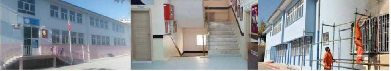
İşin Adı : Muğla Milas Atatürk İlkokulu Onarım işi
