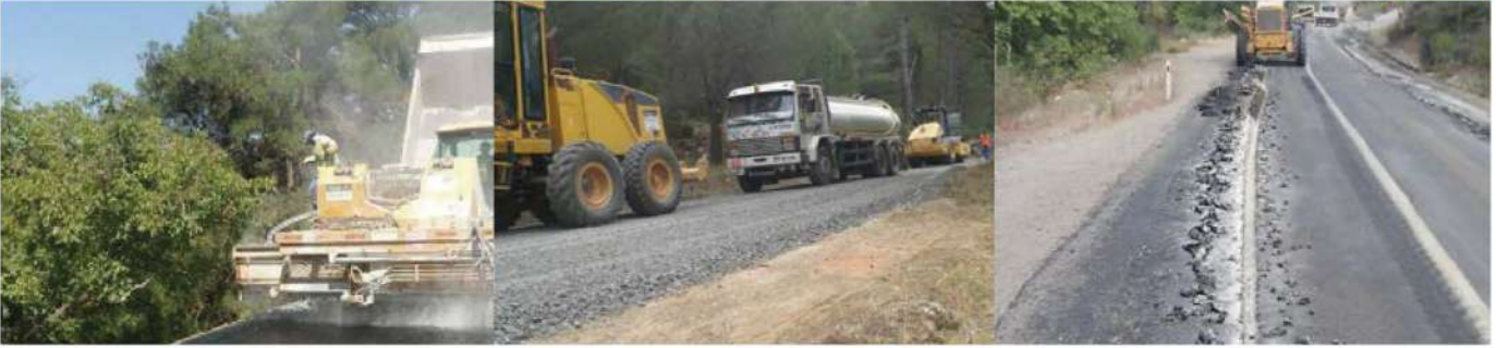
İşin Adı : Tire Bölgesinde Plentmiks Temel ve sathi kaplama yapılması işi
